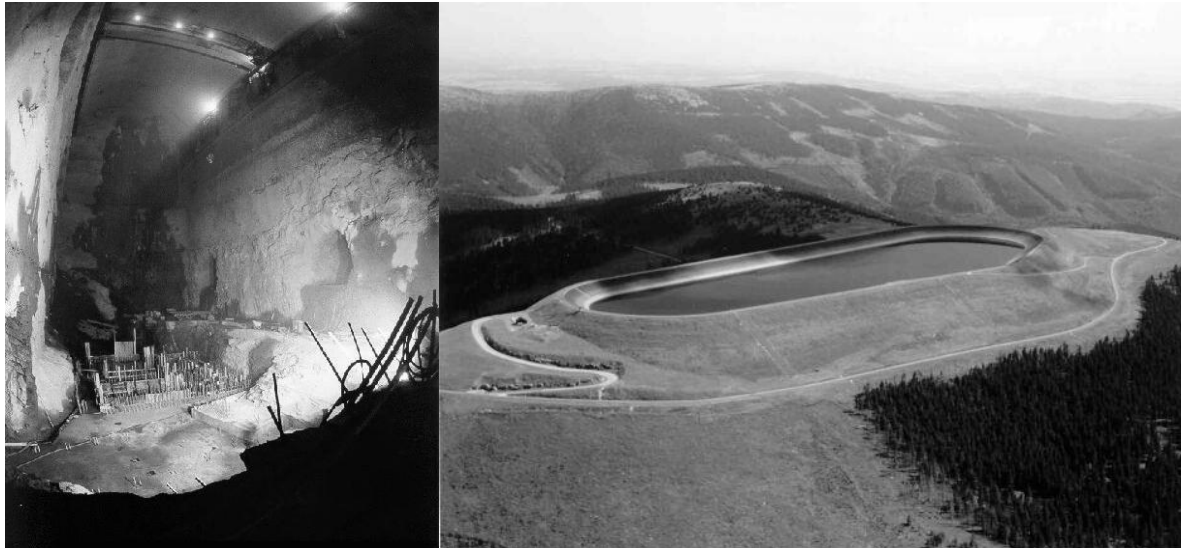
Přečerpávací elektrárna Dlouhé Stráně
