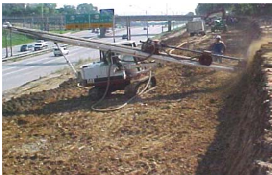
Vrtané injektované hřeby (Iowa, USA)
