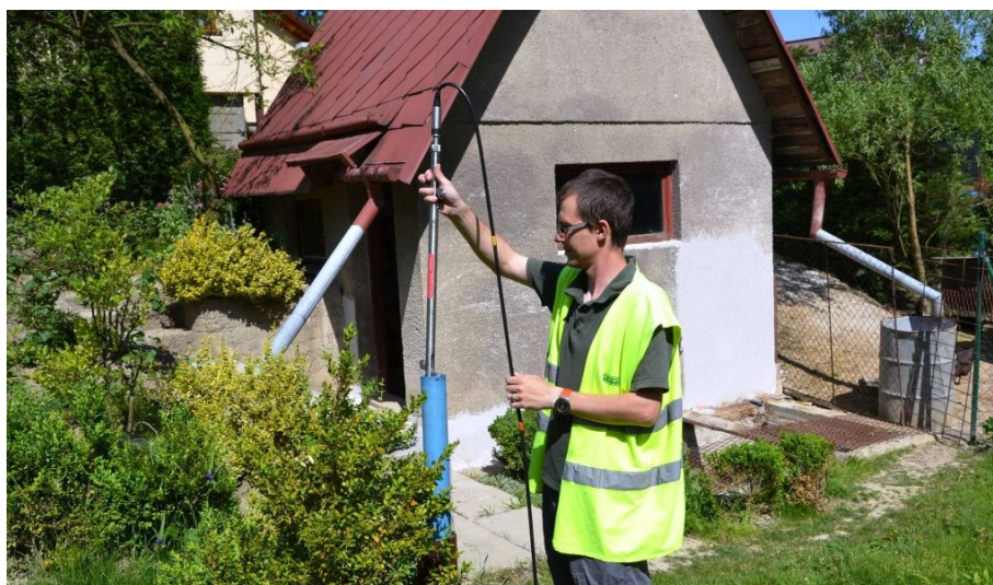
Obr. 16 Zavádění inklinometrické sondy do vrtu
