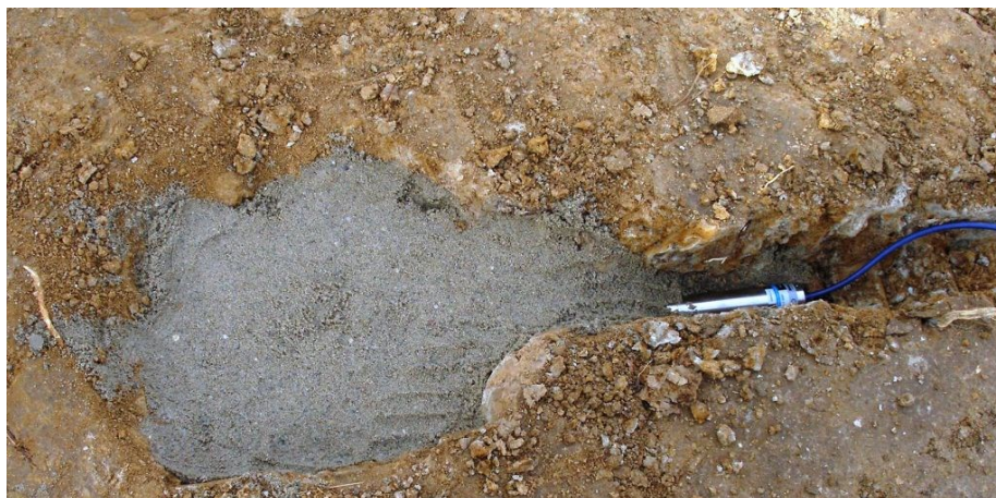
Obr. 11 Nainstalovaná tlaková buňka
