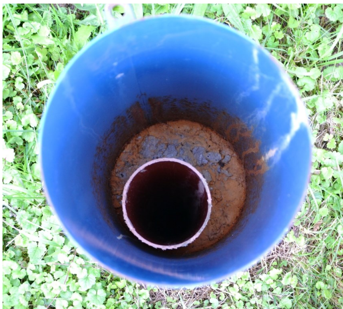
Obr. 5 Ústí vrtu s viditelnou výpažnicí
