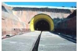
Železniční tunel Olbramovice
