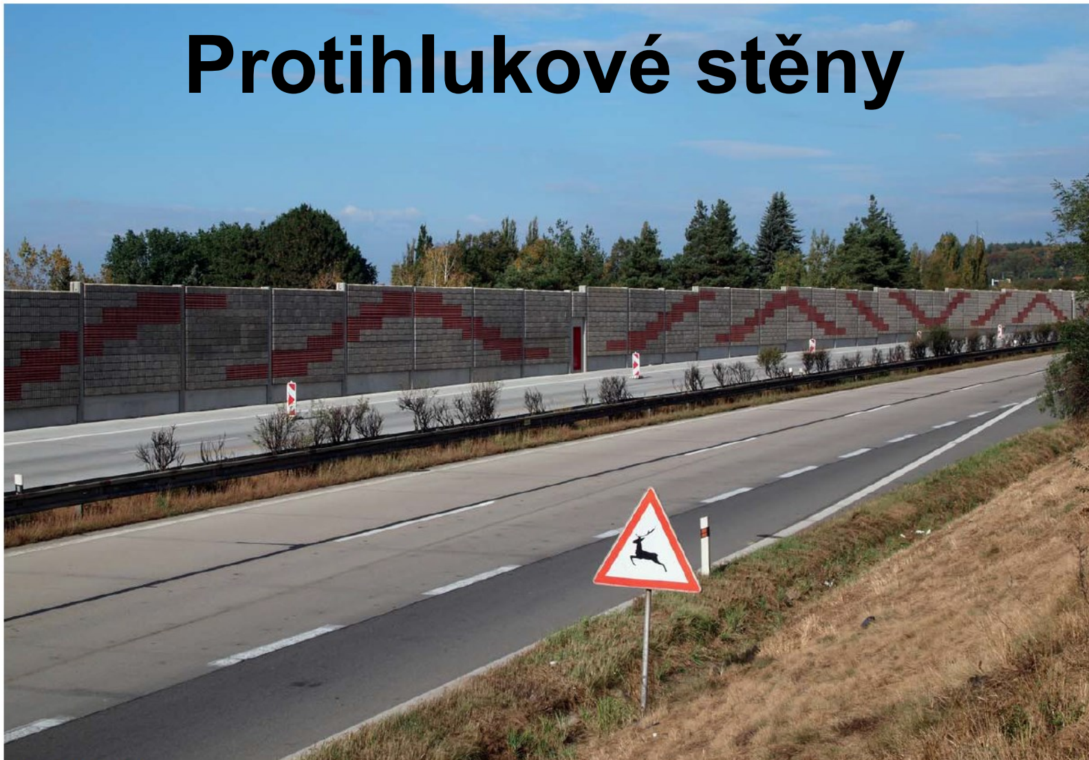
Protihluková stěna na dálnici D1, Vokč Mezříč
