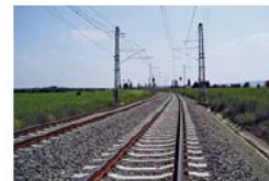
Modernizace trati Červenka–Zábřeh na Moravě
