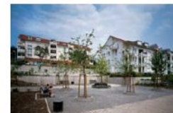
Bytové domy Stuttgart (Německo)
