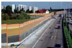
Protihluková stěna na dálnici D1, Starý Liskovec
