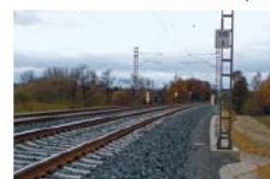
Modernizace trati Votice–Benešov u Prahy
