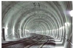
Železniční tunel Krasňov
