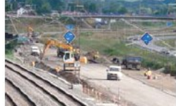
Silnice V11 Hrádek – průtah obcí
