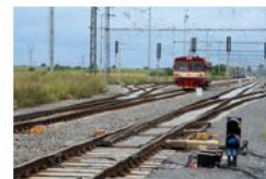
Optimalizace trati Břeclav–st. hranice ČR/SR
