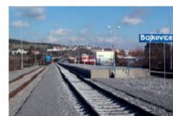
Rekonstrukce žst. Bojkovice
