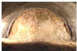
Železniční tunel Tomice I
