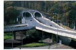
Tunel Pražská radiála, VMO Brno
