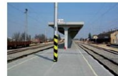
Modernizace trati Piešťany–Nové Mesto n. V. (Slovensko)
