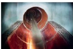
Kanalizace v Ostravě – projekt ISPA
