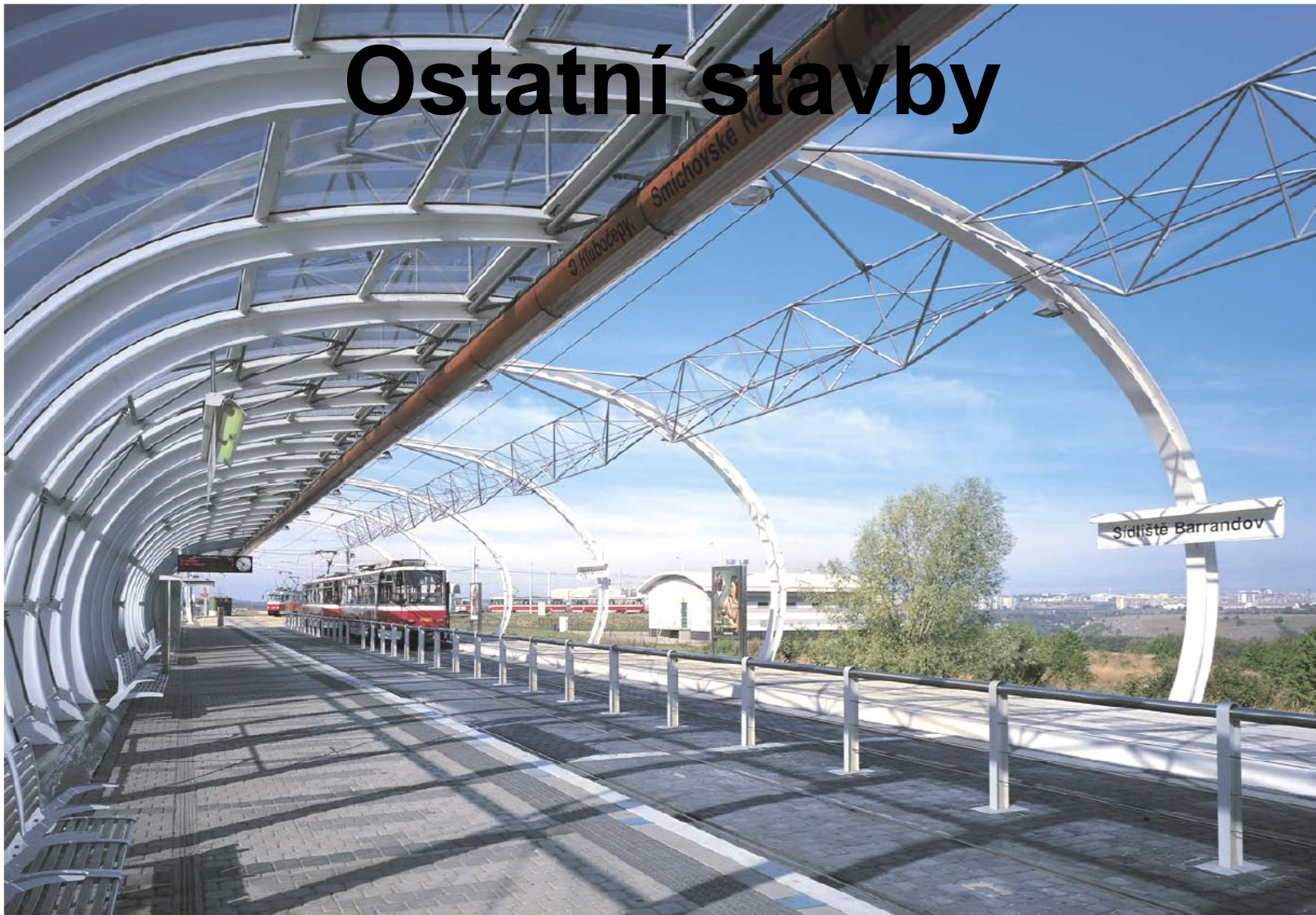
Tramvajová trať Hlubočepy–Barrandov, Praha
