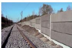
Protihluková stěna na trati Zbiroh - Rokycany - Holoubkov
