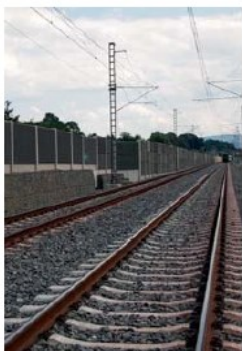
Protihlukové stěny na trati st. hranice SR - Bystrice n. O.
