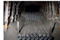
Palladium II – pfeřozky kabelovodů, Praha
