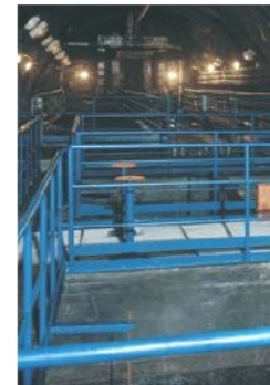
Podzemní ČOV Pac pod Sněžkou
