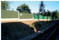
Protihlukové stěny na trati Nová Ves - Česká Budějovice
