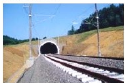
Železniční tunel Hnívkov I
