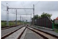
Protihluková stěna ve zhlaví železniční stanice Lanžhot
