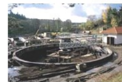
ČOV Zdráv nad Sázavou
