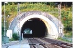
Železniční tunel Tatenice
