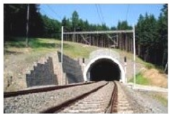
Železniční tunel Malá Huha
