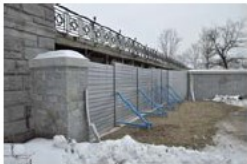
Protipovodňová opatření, Praha – Zbraslav
