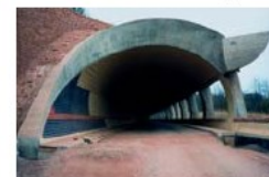
Silniční tunel Löwenherz Anweiler (Německo)
