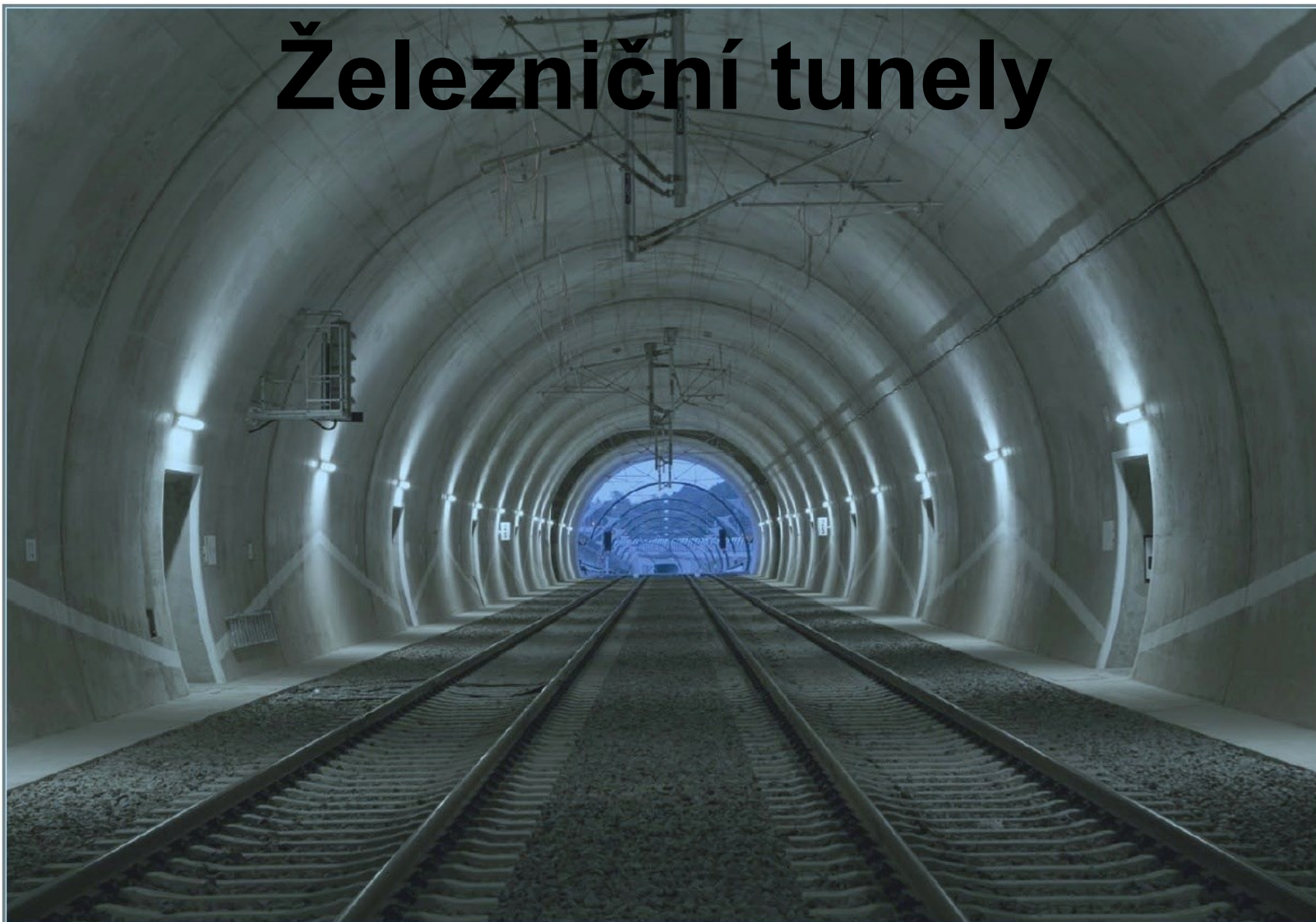
Železniční tunely Nové spojení, Praha
