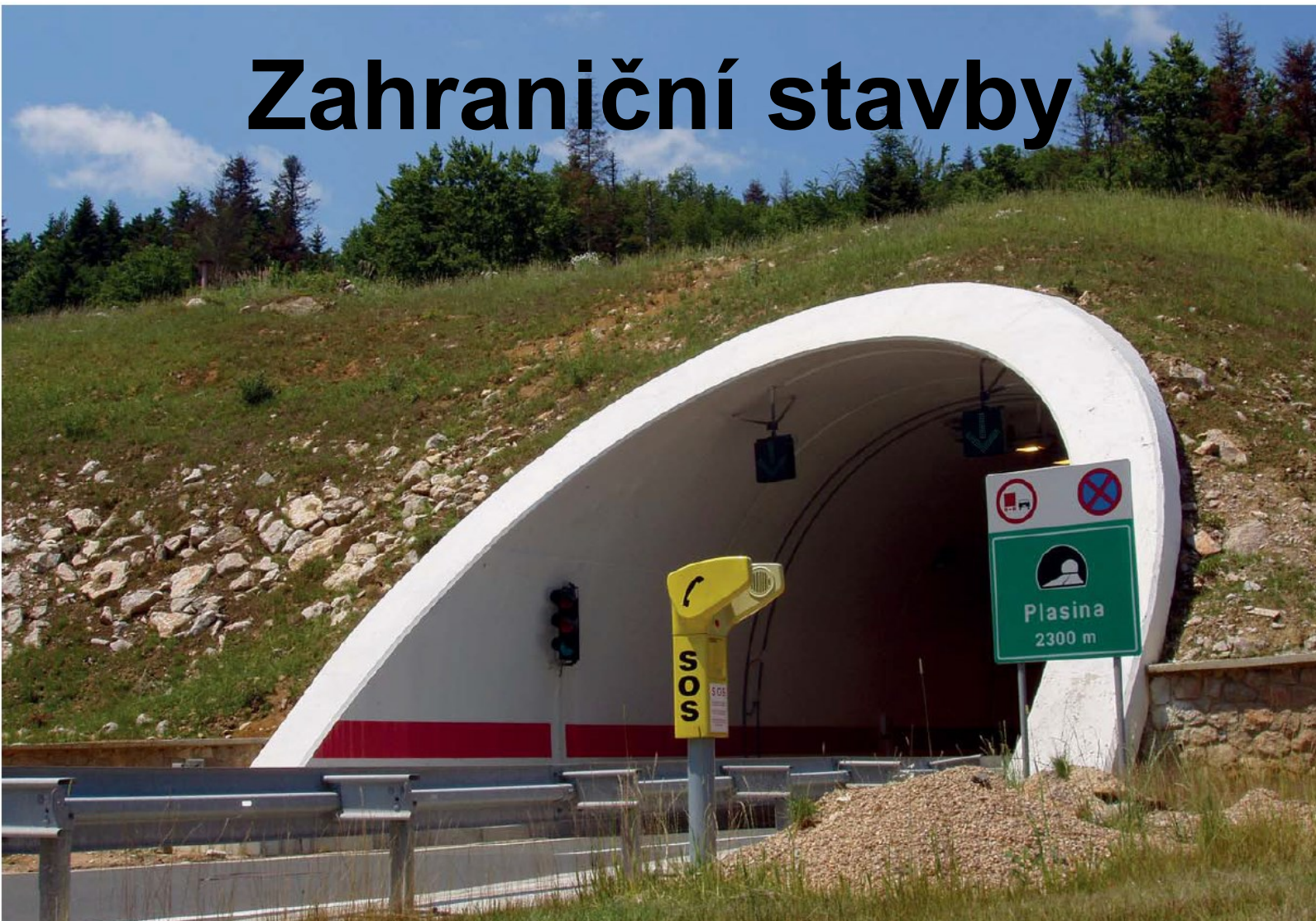
Silniční tunel Plasina (Chorvatsko)
