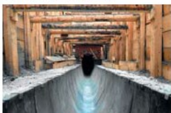
Kanalizace Svatoslavova, Praha
