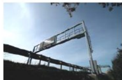
Zařízení pro provazní informace na dálnicích D1, D2 a D5
