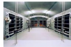
Technické zázemí tunelu Mrázovka, Praha
