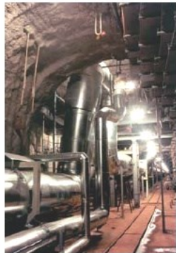
Primární kolektory Brno – kolektor Tkalcovská
