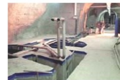
Podzemní ČOV Loket
