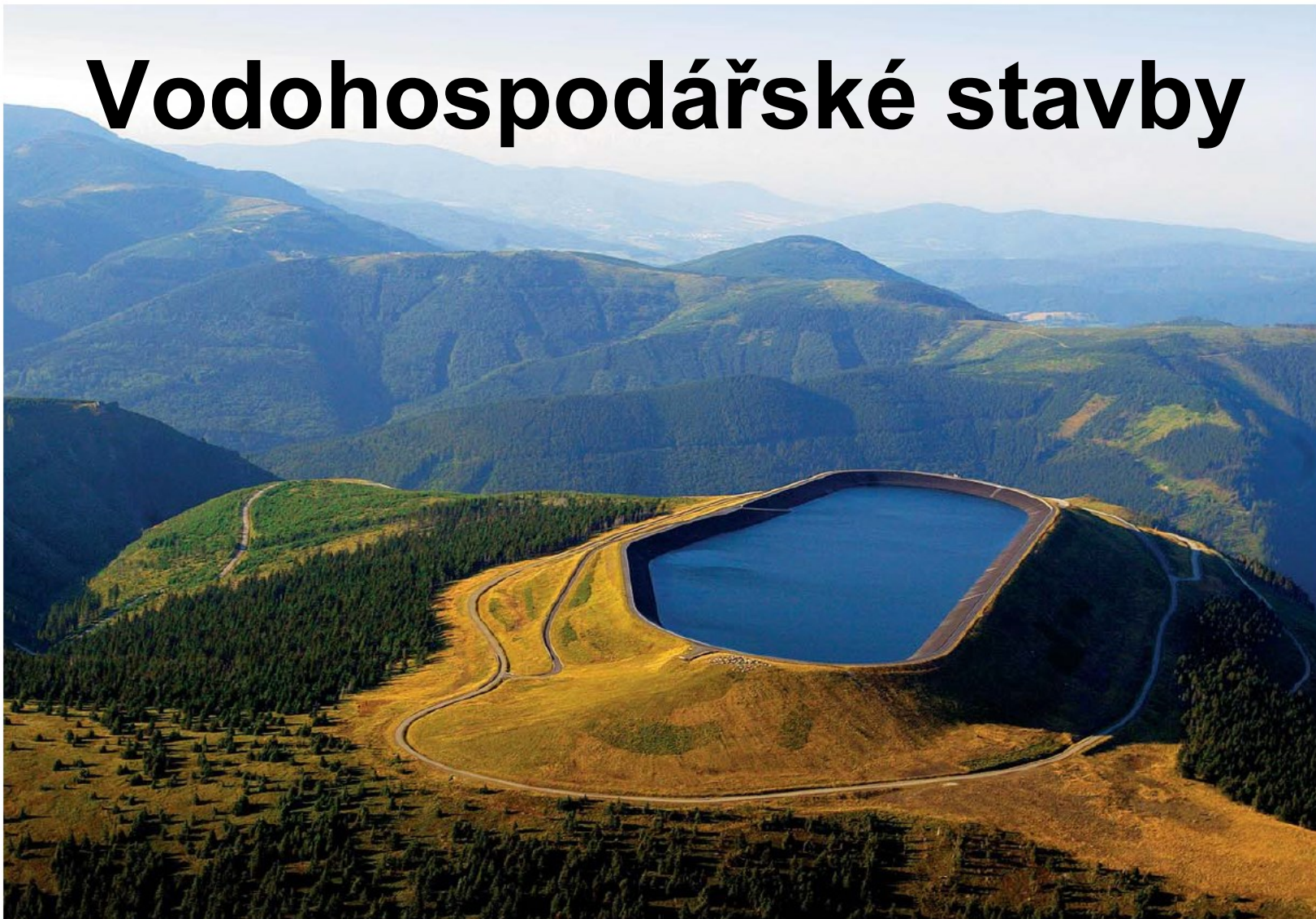
Přečerpávací vodní elektrárna Dlouhé Stráně
