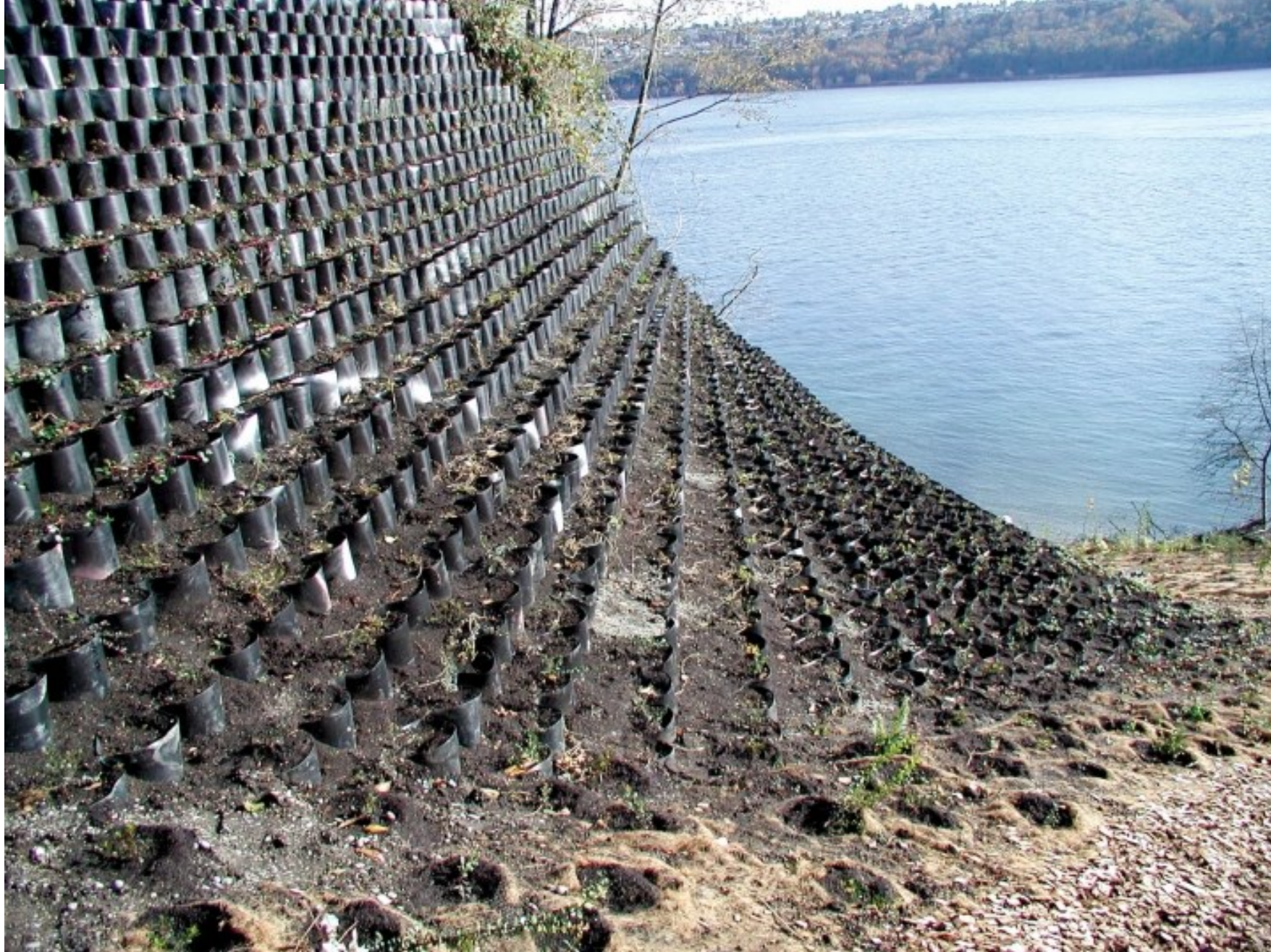
Obr. 12: Detail proměnné geometrie svahu a povrchové úpravy
