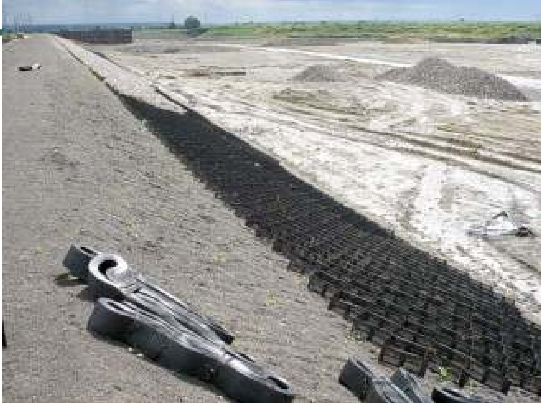
Obr. 7: Znáznornění skladby povrchu svahu
