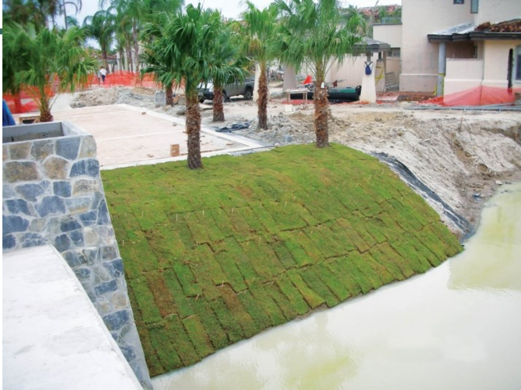
Obr. 16: Finální vzhled části chráněného svahu koryta vodního toku
