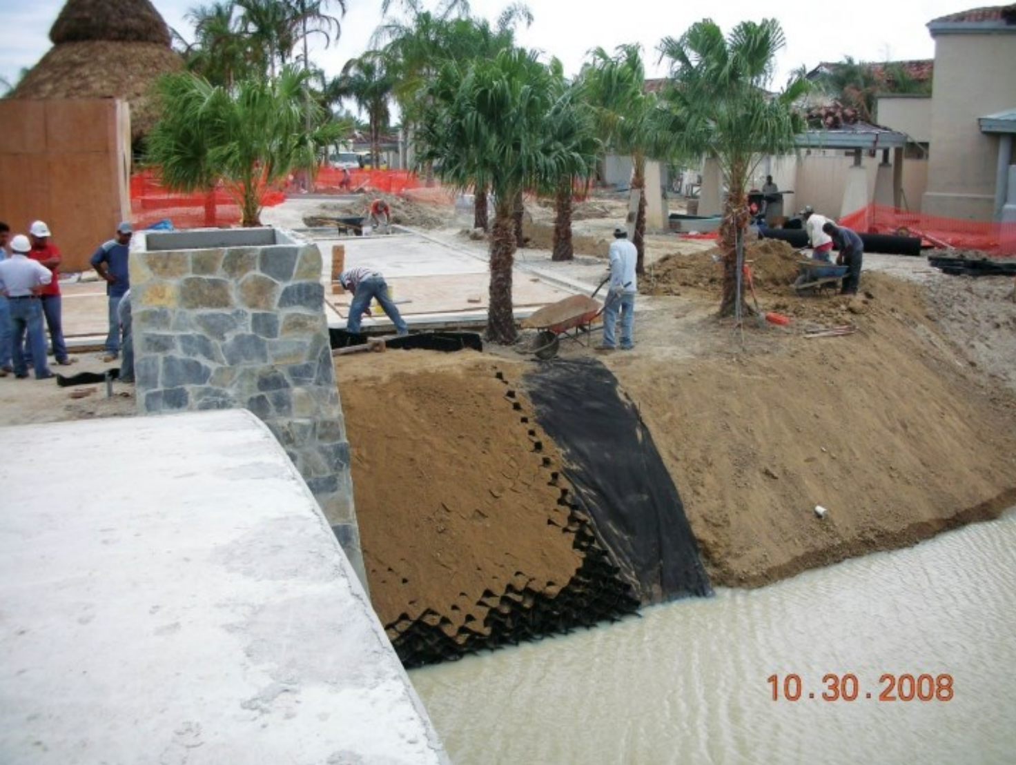
Obr. I4: Pokládka jednotlivých vrstev
