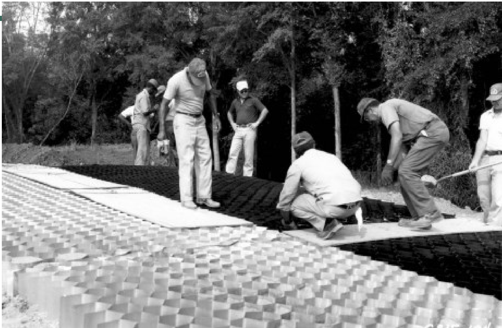
Obr. 1: Testování polyethylenových a hliníkových geobuněk na pokusné stanici Vicksburg, kolem roku 1979
