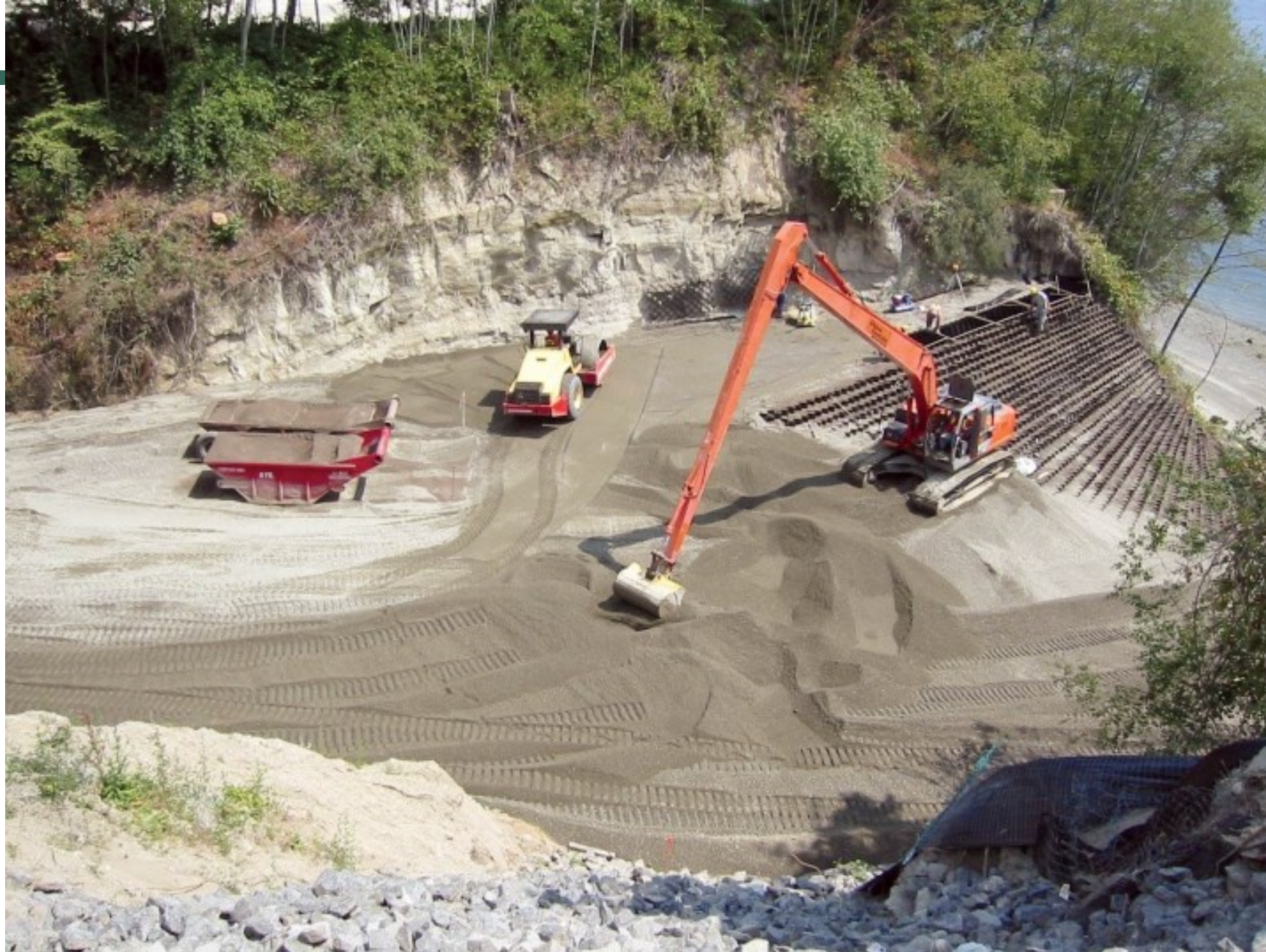
Obr. 9: Průběh stabilizace svahu
