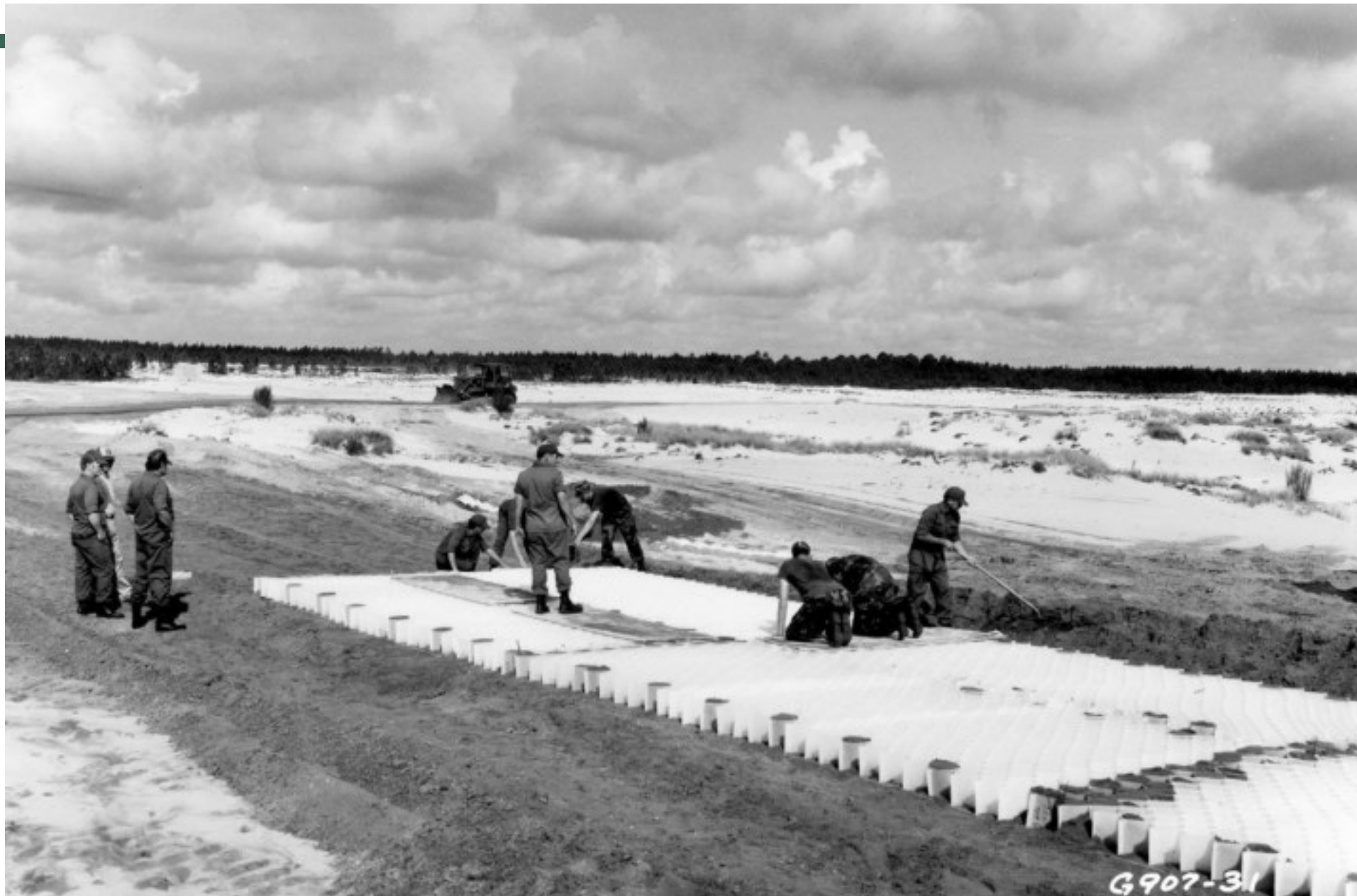
Obr. 2: Testování polyetylenových geobuněk bez UV stabilizace v raných 80. letech minulého století
