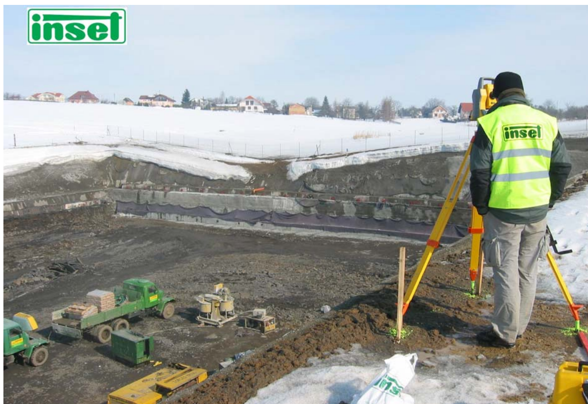
Obr. 15.2 - Monitoring stavební jámy geodetickými metodami (foto: Inset)
