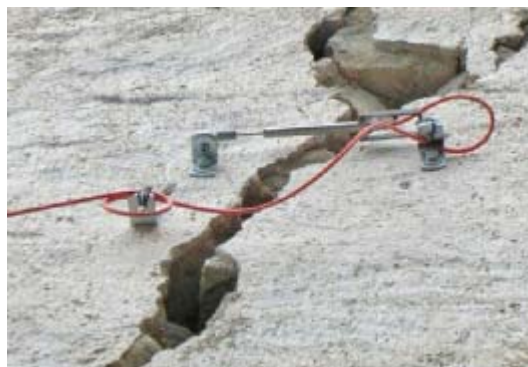
Obr. 5.3 – Ukázka monitoringu trhliny dilatometrem (zdroj: www.solexpert.com )
