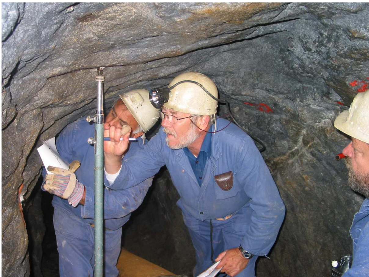
Měření konvergence důlního díla pomocí konvergenční stojky
