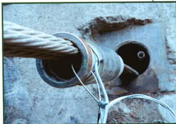
instalace snímače na zemní kotvu
