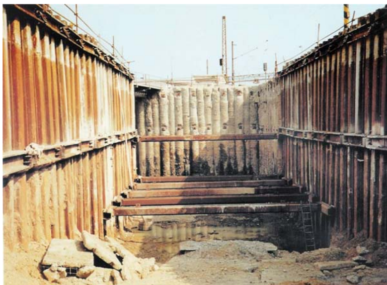
Obr. 5. Elektrárna Mělník, výklopník vápence (1994) - zapažení stavební jámy
