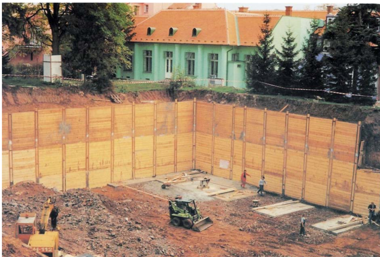
Obr. 7. Zajištění stavební jámy v Brně kotveným záporovým pažením (1996)
