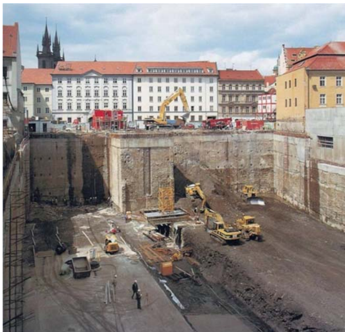
1. Obchodní centrum Mysl bek (1995) – stavební jáma, hluboká 15-17 m, je zajištěna kotvenými konstrukčními podzemními stěnami. Okolní objekty a komunikace byly zabezpečeny tryskovou injektáží a mikropilotovými stěnami.
