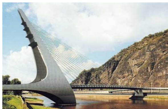
2. Nový silniční most v Ústí n-Labem (1998) – vlevo: jediný pylon mostu je založen v jímce z podzemních stěn vyhloubené až na pevný skalní podklad. Vpravo: pohled na dokončenou mostní konstrukci
