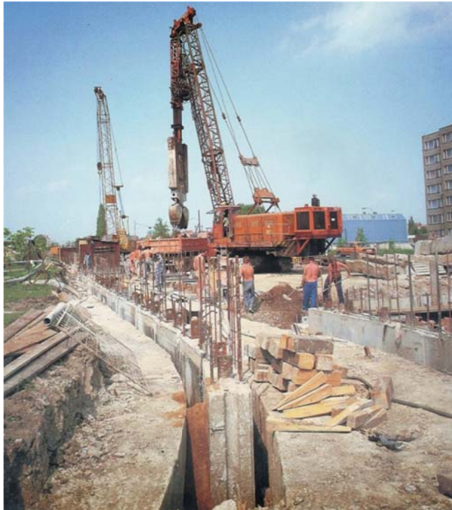
Obr. 9. Slánského ulice, podchod pro pěší (1990) – vybudovaný pod frekventovanou vozovkou z prefabrikovaných podzemních stěn
