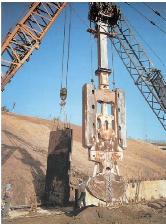
Obr. 8. Famírova ulice (1989-1990) – úprava komunikace prefabrikovanými podzemními stěnami
