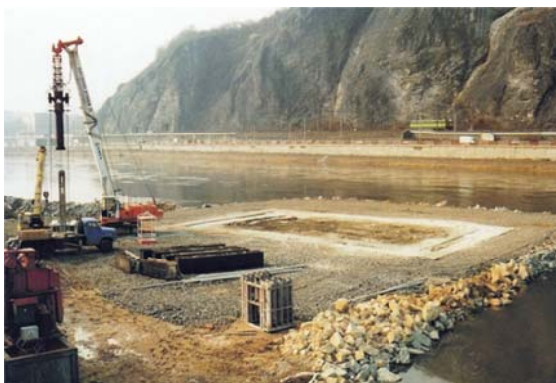
2. Nový silniční most v Ústí n-Labem (1998) – vlevo: jediný pylon mostu je založen v jímce z podzemních stěn vyhloubené až na pevný skalní podklad. Vpravo: pohled na dokončenou mostní konstrukci
