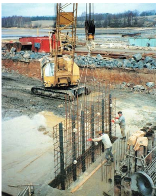
3. Most přes vodní nádrž Skalka u Chebu (1994) – opěry i pilíře mostu mezinárodní silnice E48 jsou založeny na elementech železobetonových podzemních stěn.
